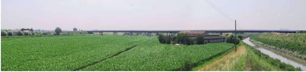
Figura 8-2 Aree agricole, arginature ed edificazione diffusa
