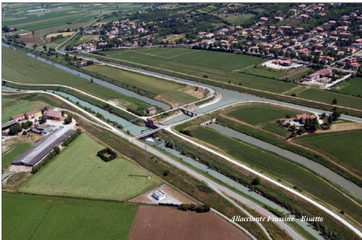
Figura 9: Foto del manufatto allacciane Frassine- Bisatto (immagine tratta dal PGBTT del Consorzio di bonifica Adige Euganeo). A sinistra il fiume Frassine con andamento sinuoso raggiunge il nodo idraulico, dove è presente il sostegno Brancaglia (riconoscibile dalla struttura metallica in corrispondenza del ponte).
